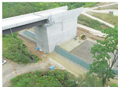
施工中の様子
