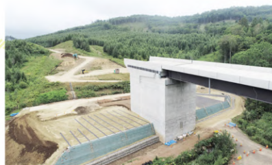
施工中の様子
