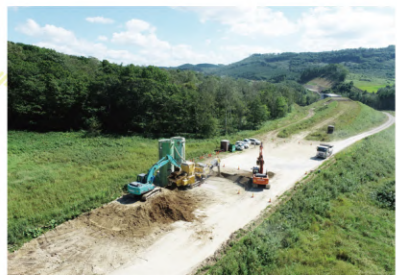
地盤改良中の様子
