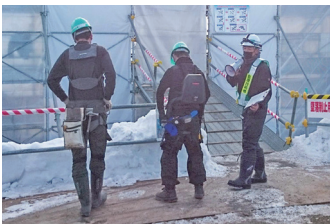
▲ 身体への負担が大きい動作を補助する道具「パワーアシストスーツ」を用いた施工が紹介されました
