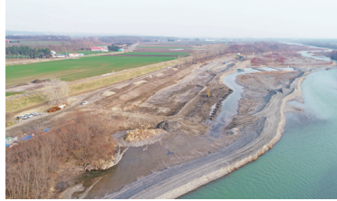
▲河道切替後の空撮写真
