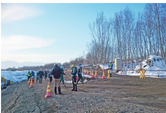
▲ 十勝川改修工事の内、川西築堤河岸保護外工事（西江建設㈱施工）を3班に分かれパトロール
