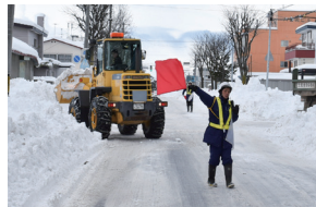
除雪作業の様子
