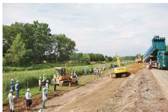
▲ 施工中の現場を2班に分かれパトロール
