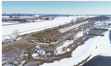
▲令和4年2月10日時点での施工状況
