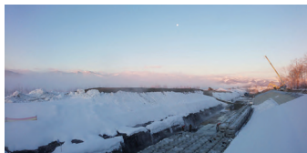
▲月と朝陽に照らされる現場
