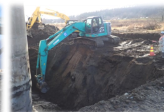
橋脚まわりの掘削
