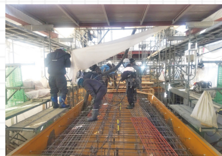
コンクリート打設作業中の様子
