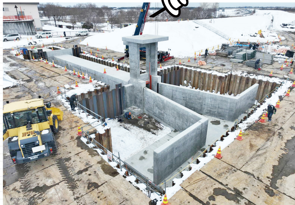
施工中の様子
