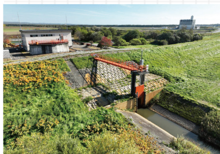
着工前の様子
