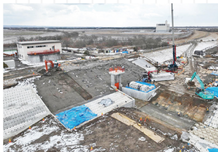
施工中の様子
