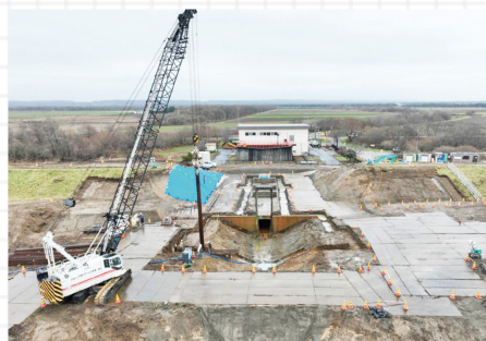
施工中の様子
