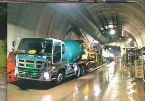
北海道新幹線 昆布トンネル(ニセコ町) ※現在施工中
