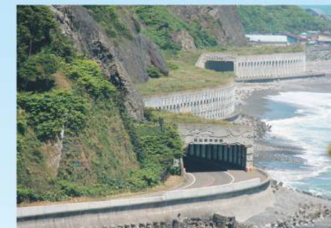
浜フンベ覆道(黄金道路)(広尾町)
