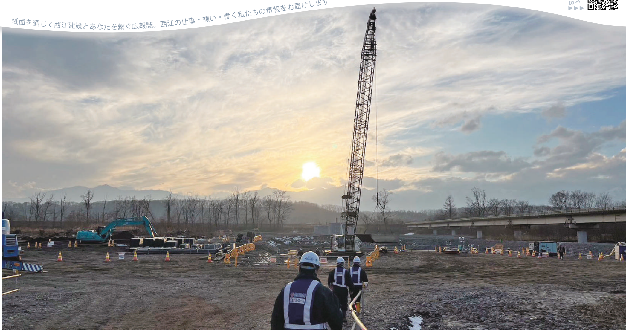
熊牛御影線十勝橋架換工事（補正）（明許）外において、安全パトロール中に撮影した1枚。夕焼け空にクレーンが力強くそびえる（撮影：経理課 吉川）
