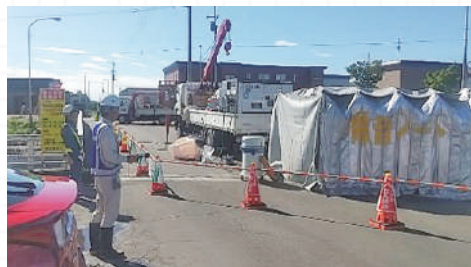
西3号橋 ハンドブレイカーを使って既設のコンクリートを壊す作業では大きな音が発生します。防音ゲート（写真内右）の中で作業することで騒音を低減しています。
