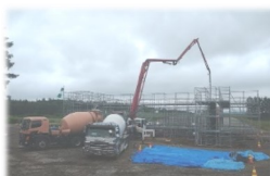
▲ コンクリート打設
