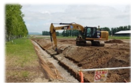
▲ ICT建機による 法面仕上げ
