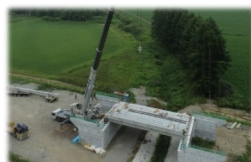
▲ プレストレスト・ コンクリート橋 架設
