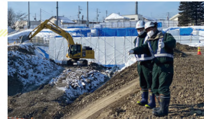
▲ 安全パトロールに同行した事務職員に現場の説明をする小野田工事長（右）
