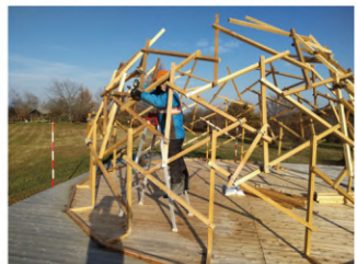
▲ドームテント撤去の様子
