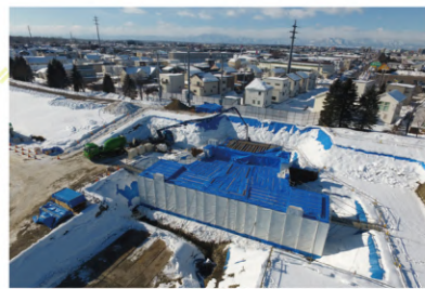
▲ 施工中の様子（東帯広樋門地区） 工事現場のすぐ近くには多くの住宅が並んでいます
