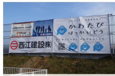
▲ 住宅街と現場の間に設置した防音フェンス
