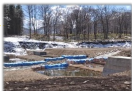
▲ 施工前の様子
