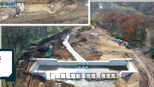
13号床固工 施工箇所 先行してほぼ完成
