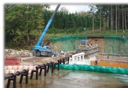
▲仮締切と切替えの様子 写真中央の土嚢(どのおう)で河川を仮締切している。奥側に施工するため既に施工済の手前側に河川の流れを切替えている。手前側の施工中は奥側に水が流れていた。
