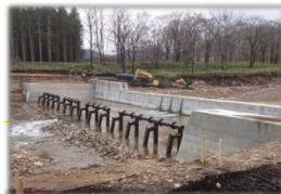
▲ 施工中の様子
