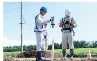
施工中の現場で丁張設置の体験
