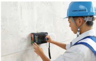
音波で橋脚内部の鉄筋の位置を確認する鉄筋探査を体験
