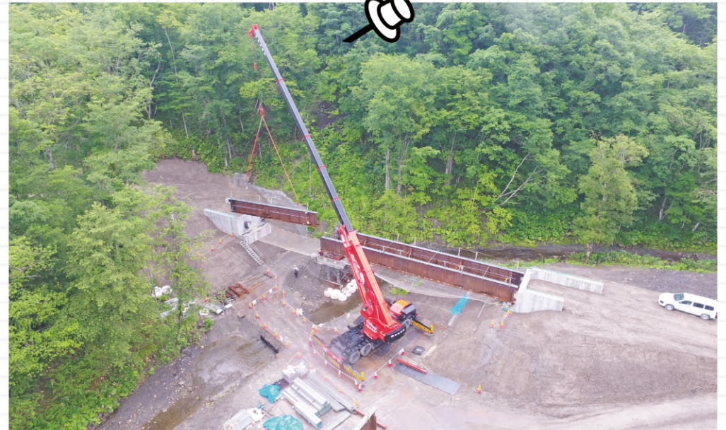
菊面沢橋 施工中の様子 (施工箇所：上流工区)
