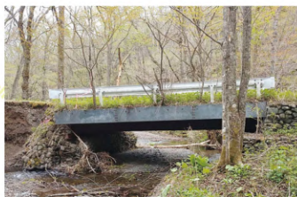
台風の被害によって土台が壊れた橋梁
