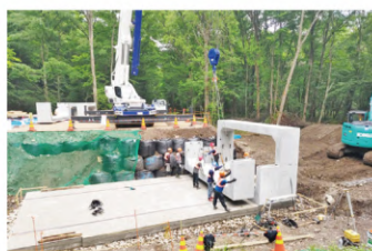
ボックスカルバートを布設する様子
