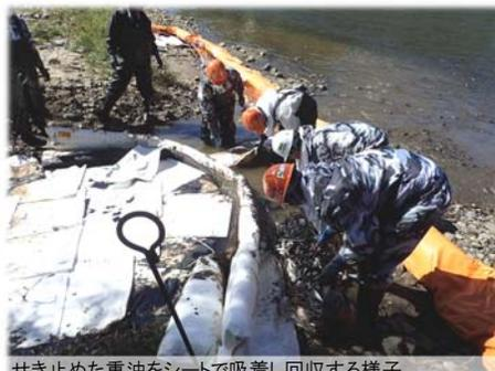
せき止めた重油をシートで吸着し回収する様子
