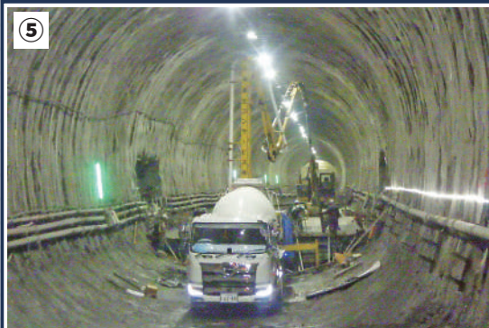
⑤ インバート（トンネルの底面を逆アーチ型にコンクリートで固めた部分）施工の様子。インバートがあることで、地山からの圧力に耐える力が増加し、沈下や変形を防ぐ。
