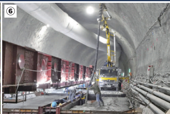
⑤ インバート（トンネルの底面を逆アーチ型にコンクリートで固めた部分）施工の様子。インバートがあることで、地山からの圧力に耐える力が増加し、沈下や変形を防ぐ。
