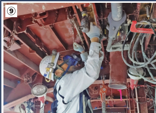
⑨ セントルの点検と、覆工後のコンクリートの表面をハンマーでたたき、空洞などがないか打音検査⑩を行う吉田主任。技術者の経験と感性・技術力が活きる場面。
