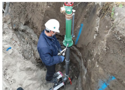
▲給水栓を設置
