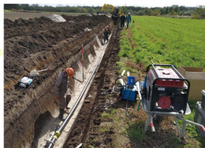
▲農業用ポリエチレン管を布設
