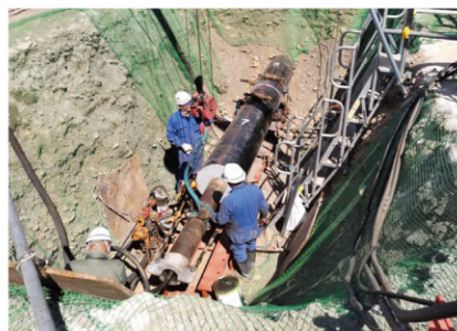
▲推進工法による施工
