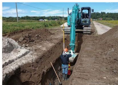
▲畑の際をバックホウで掘削
