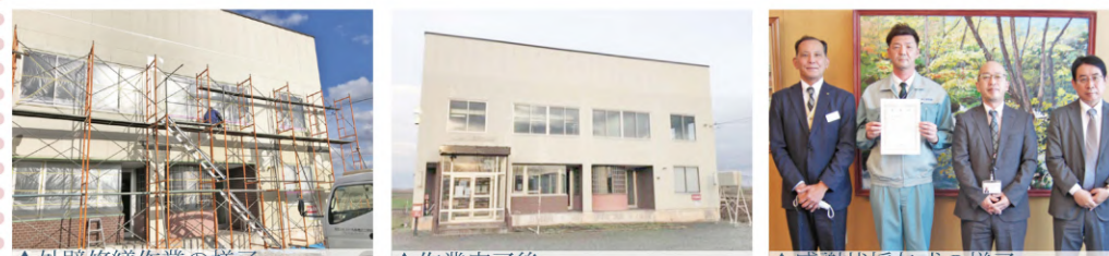
▲外壁修繕作業の様子 ▲作業完了後 ▲感謝状授与の様子
