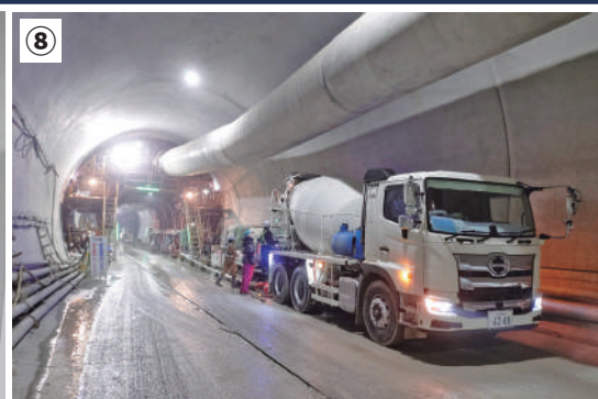
⑦ 漏水防止のために壁面に防水シートを貼付。その後、セントルという型枠を用いてコンクリートを流し込み、トンネル内部の壁面をつくる（覆工）⑧。
