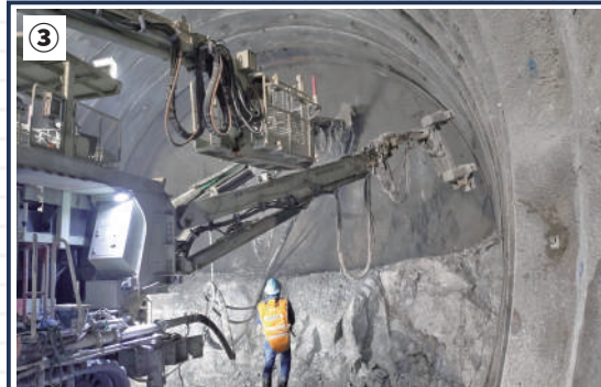
③ 吹付作業の様子。コンクリートを吹き付けることでH鋼支保工と地山を一体化させ、壁面を補強する。
