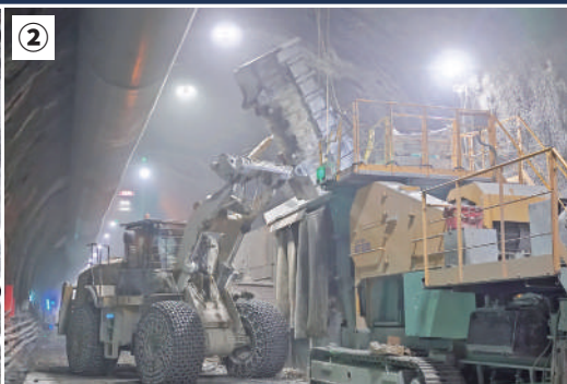
① 地山の削孔（火薬を装填するための穴をあけること）作業の様子。火薬で発破させ、砕いた岩（ずり）をホイールローダーなどで集めて②、トンネルの外に運び出す。1回の発破で数メートルずつ慎重に掘り進める、トンネル工事の最前線。
