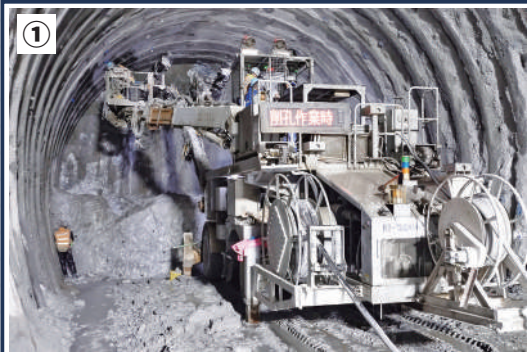
① 地山の削孔（火薬を装填するための穴をあけること）作業の様子。火薬で発破させ、砕いた岩（ずり）をホイールローダーなどで集めて②、トンネルの外に運び出す。1回の発破で数メートルずつ慎重に掘り進める、トンネル工事の最前線。
